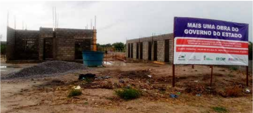
Construção da unidade de beneficiamento de Licuri, da Associação de Lagoa da Roça, em Campo Formoso
